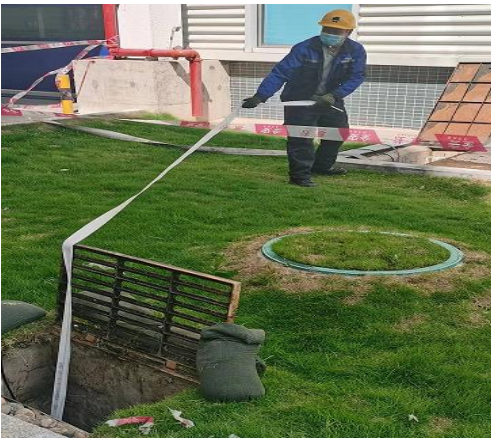
6、 采样监测： 监测组对污染雨水井进行采样检测
